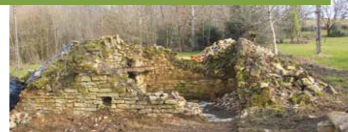
Les ruines du bâtiment du four avant sa reconstruction...
